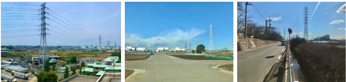
図 9-1 建設予定地周辺状況
