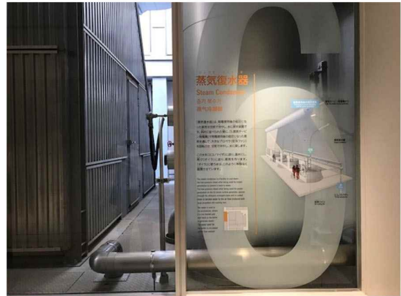
設備機器の説明パネル(順路に沿って設置) (武蔵野市クリーンセンター)
